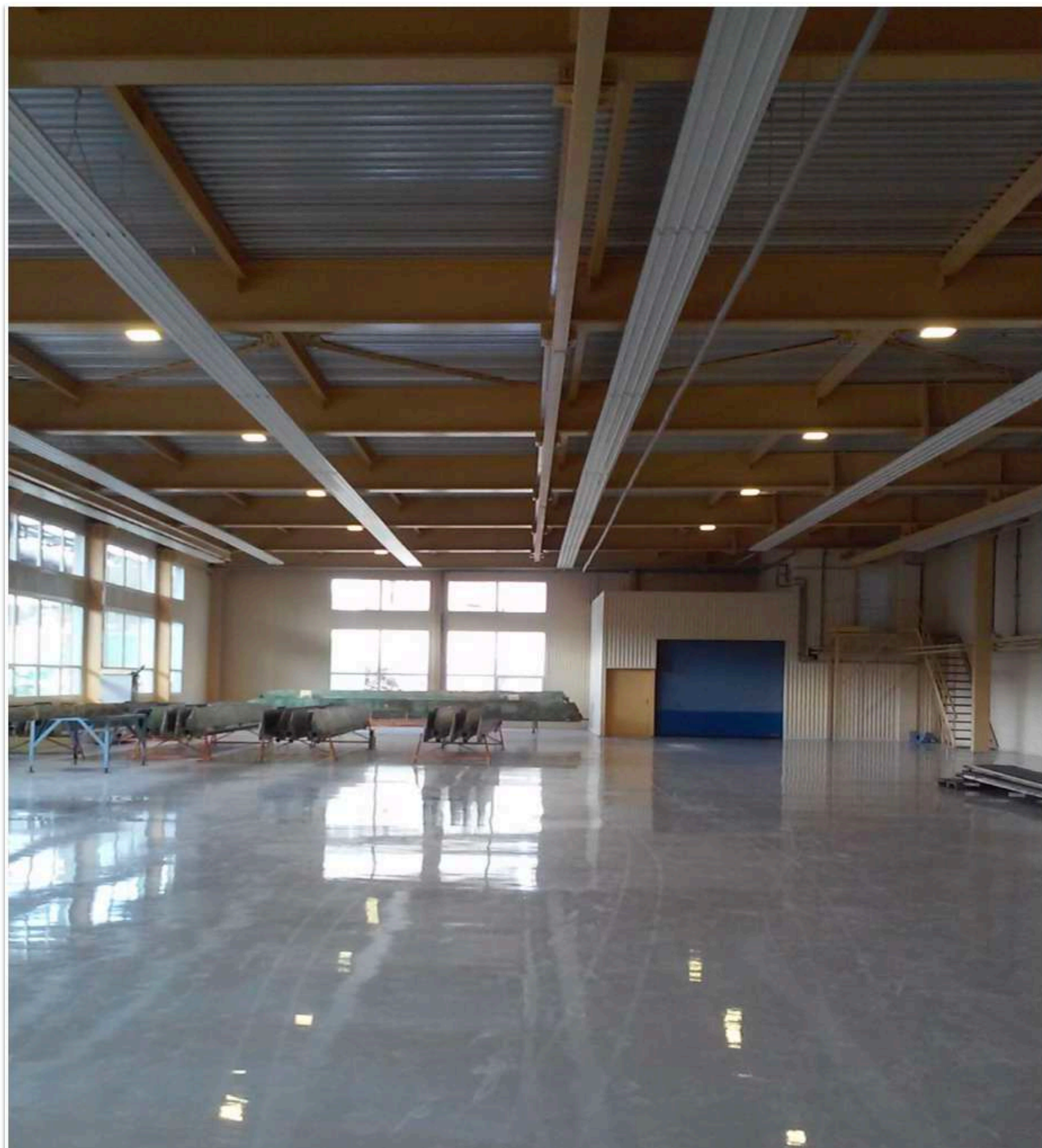
Підлога цеху після заливки фінішного шару
